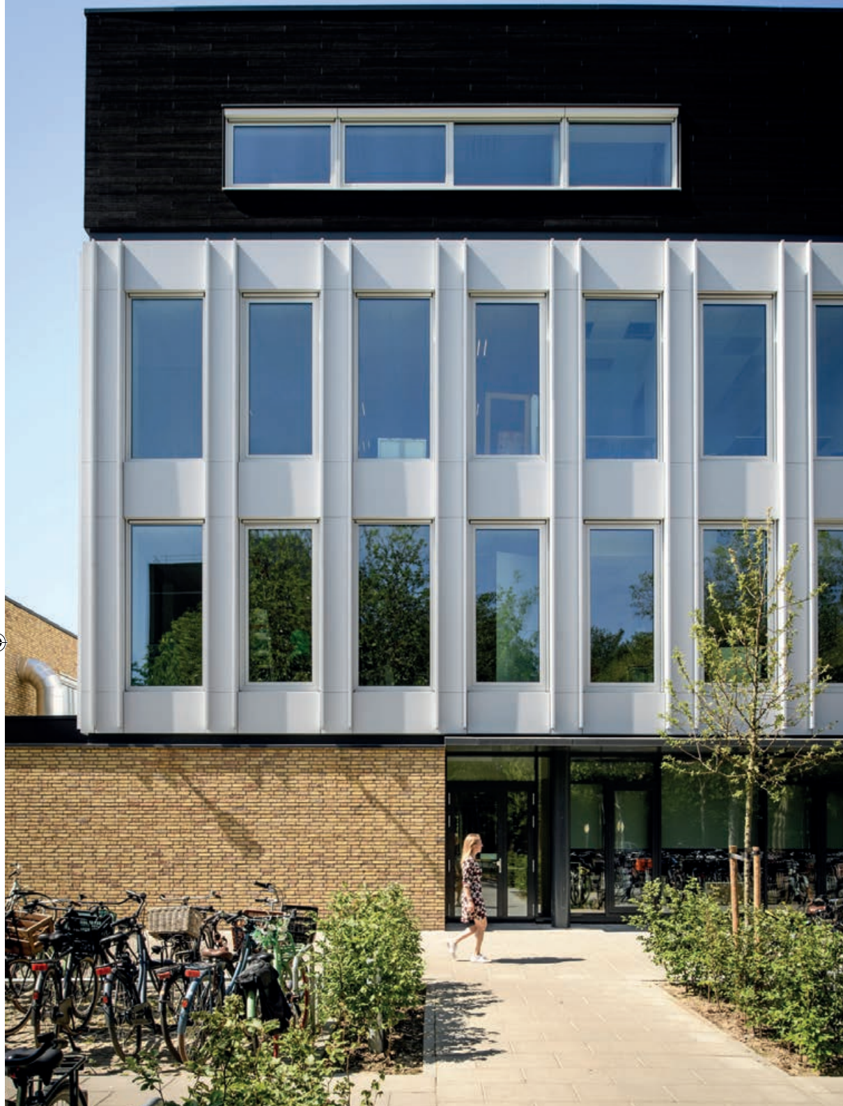
▲ Triple zonwerend glas, Tripleperform SUN van vandaglas, zorgt voor het comfort. Foto: Mike Bink voor LIAG architecten + bouwadviseurs
