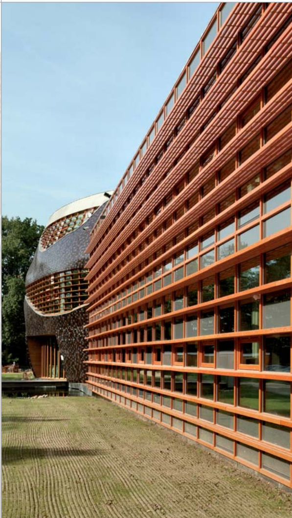
Het hoofdkantoor van het Wereld Natuur Fonds te Zeist is een CO 2 -emissievrij gebouw, mede door de drievoudige beglazing van AGC. Foto's: AGC
